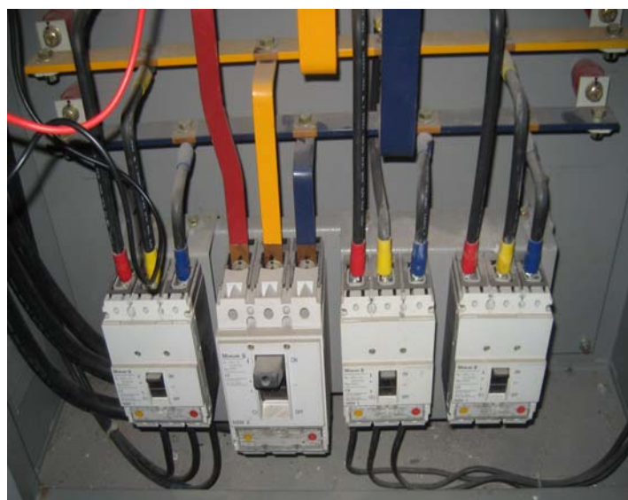
ภาพที่ 3. การติดตั้งเครื่องวัดคุณภาพไฟฟ้ากับระบบไฟฟ้า
