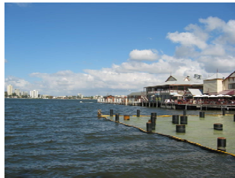
ภาพที่ 13. การใช้พลาสติกล้นดักตะกอนดินจากการก่อสร้างริมฝั่งแม่น้ำสวอน
