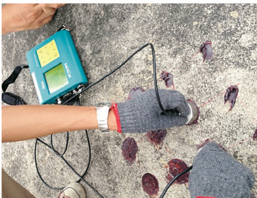
ภาพที่ 4 การตรวจสอบคุณภาพของคอนกรีต
