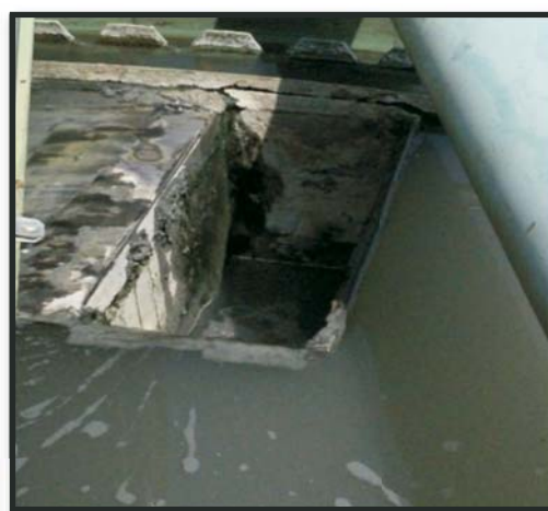
ภาพที่ 6 ช่องน้ำล้นที่ทำหน้าที่ส่งน้ำไขมันน้ำลงไปบำบัดใหม่
