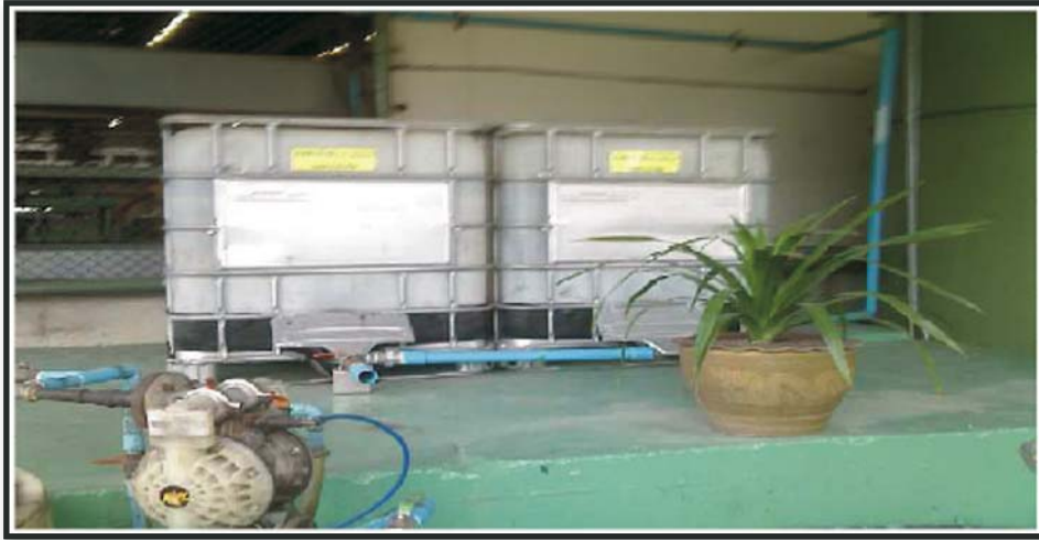
ภาพที่ 2 ถัง PE ที่ดัดแปลงให้มีลักษณะการทำงานคล้ายถังดักไขมันเพื่อเก็บน้ำมันหล่อเย็น
