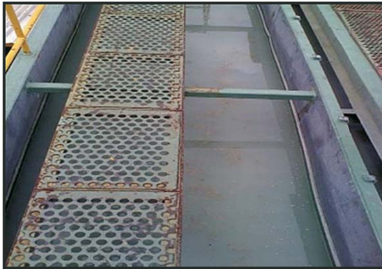
ภาพที่ 4 น้ำเสียก่อนปรับปรุงระบบ มีตะกอนลอยและขุ่น บางครั้งมีคราบน้ำมันลอยอยู่ผิวน้ำ
